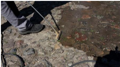
Wie ein kleiner Besen sieht die Ausbringlanze aus, mit der das heiße Wasser auf dem Weg ausgebracht wird.
